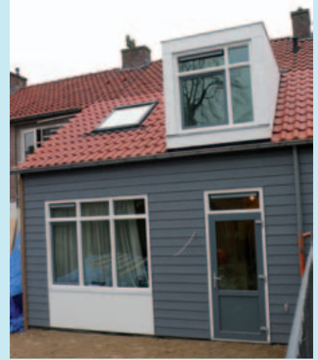
Modelwoning Duurzaam renovatieproject van TBV Wonen: 254 woningen in de Tilburgse wijk Berkdijk
